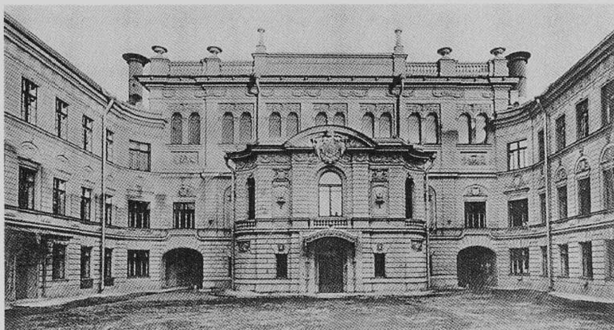
Здания Капеллы на Мойке. 1886–1889.
