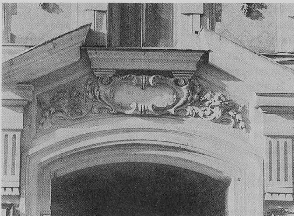
Дом Л.Н. Бенуа. Деталь фасада
