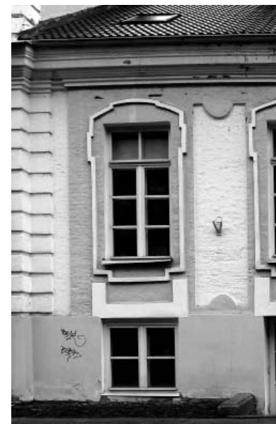
Фрагмент фасада. 2013. Фотография автора
