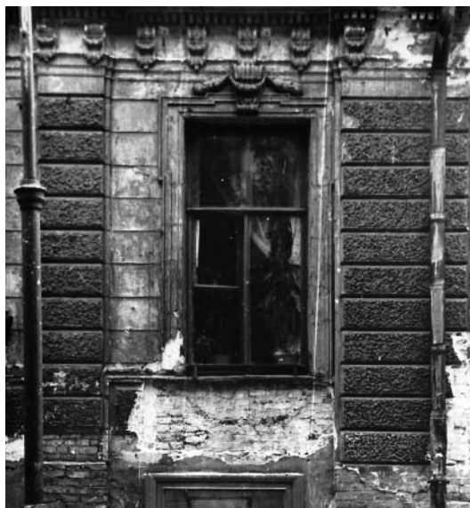
Окно с начатой расчисткой подоконной стенки. 1968. Фотография автора
