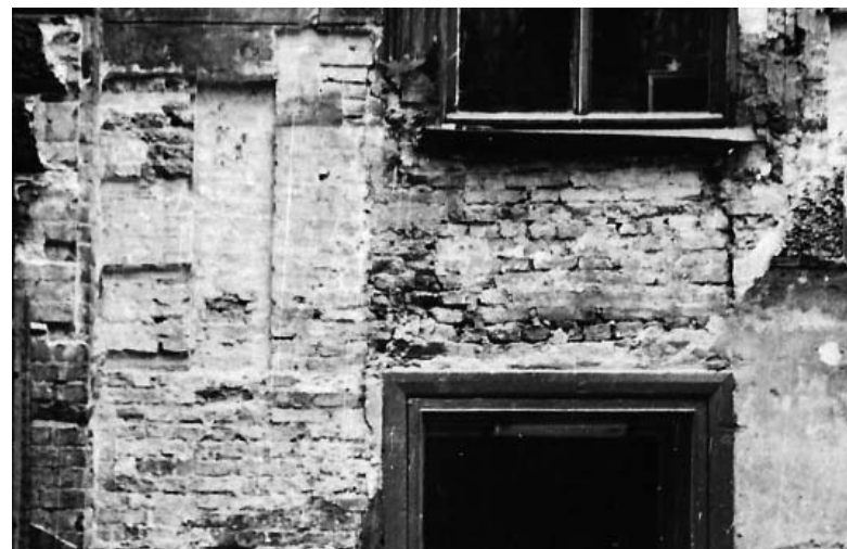
Выявление наличника, ниши и рустованных лопаток. 1968. Фотография автора
