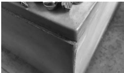
Скол плит и сдвиг крышки на надгробии императора Александра III. Фотография сентябрь 2015 г.
