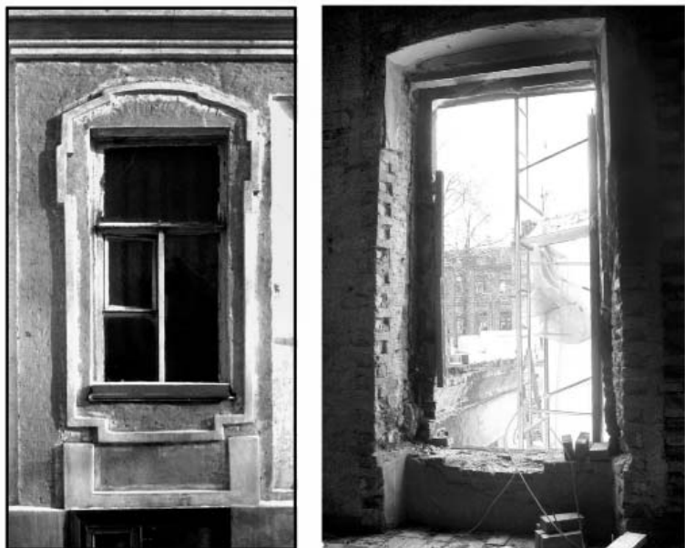
Конструкция оконного проема. Фотографии автора 1983 и 2007 гг.
